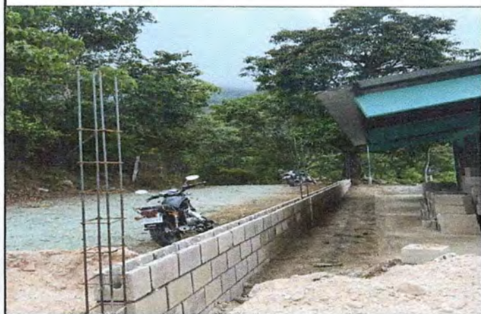
Foto 3: Mejoramiento de cerco de malla en el área Perimetral.
