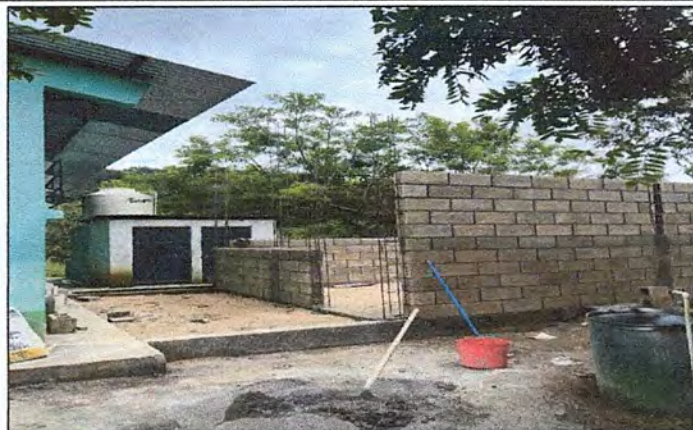
Foto 2: Mejoramiento de Instalaciones de cocina de block
