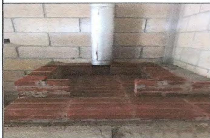
Foto 4: Mejoramiento e instalación de estufa de leña.
